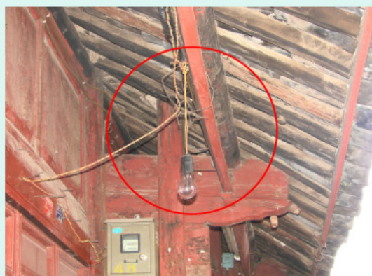
古城灯光亮化工程实施前
